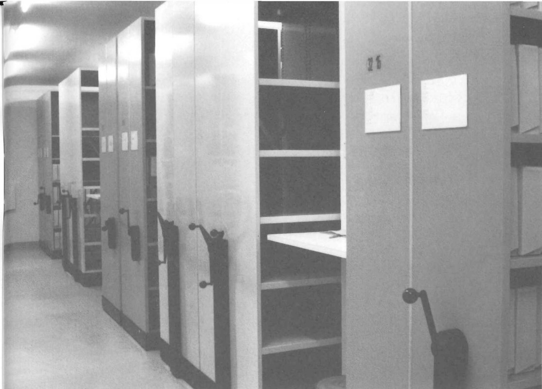
Kombination neuer und alter Rollgestelle im Magazin des 3. Obergeschosses (helle Wände und dreiteilige Kurbel neu, dunkle Wände und einteilige Kurbel alt), vgl. S. 7
