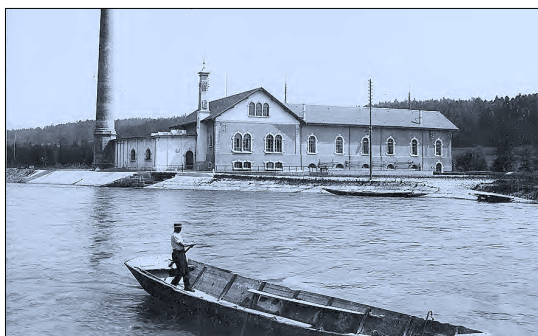
Das Elektrizitätswerk Rathausen an der Reuss bei Emmen mit dem 1900 erbauten Hochkamin. QUELLEN STAATSARCHIV
